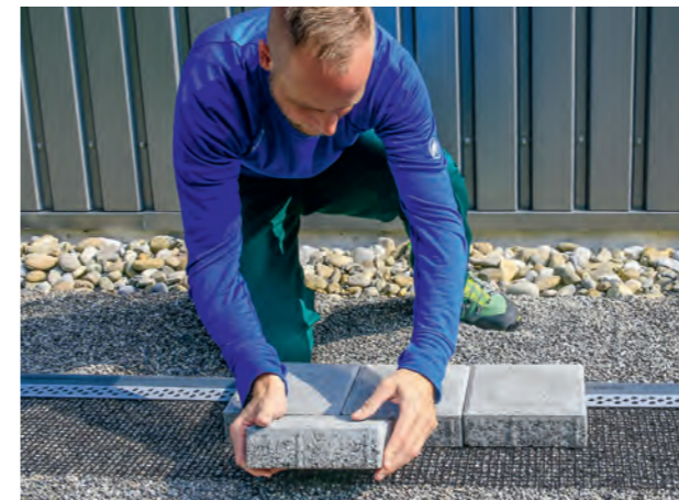
Mit dem Eigengewicht der Steine verankert sich das Netz dauerhaft im Splitt.
