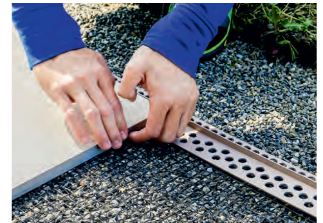
Mit steifix netz dim.10 werden die Keramikplatten einfach und schnell fixiert.
