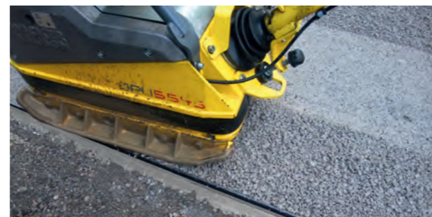
steinfix stahl hält den Kräften grosser Vibroplatten problemlos stand.
